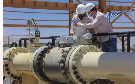
همکاری در تولید و بومی‌سازی ورق‌های A516Gr.60 Nace جهت شیرآلات MBV طرح ملی و استراتژیک خط لوله گوره-جاسک
